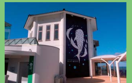
のとじま臨海公園水族館 元漁業研修センター改修工事
