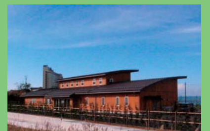
七尾市防災広場管理棟建設工事
