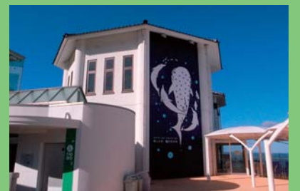
のとじま臨海公園水族館 元漁業研修センター改修工事
